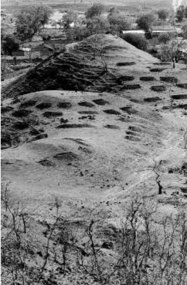
कन्दूर की रेखा पर बनाई गई खंती को कन्दूर ट्रेन्च कहते हैं। कन्दूर खंती का लेवल (level) एक समान होने के कारण बहता पानी उसमें भर के ठहर जाता है। कन्दूर ट्रेन्च एक सरल और कम लागत वाला उपाय है जिसका उपयोग प्रायः जलग्रहण क्षेत्र के ऊपरी रिज (ridge) क्षेत्र में पानी और मिट्टी के कटाव को रोकने के लिए किया जाता है।
